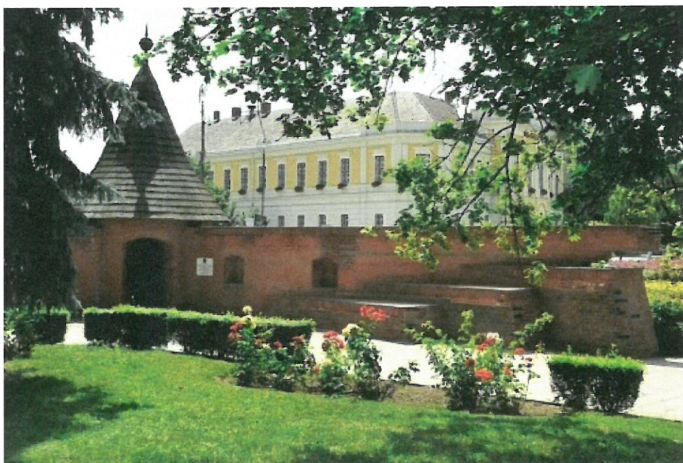
Hajdúnánási Református Templomerőd felújítása
